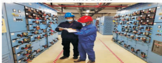
图2.4.4 电气总包现场安装
