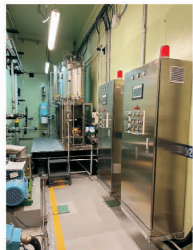
图2.4.5 仪表总包现场安装
