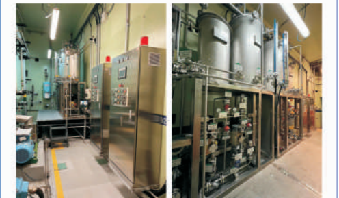
图2.2.7 一回路系统锌添加装置
